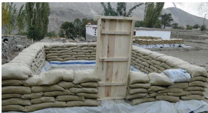
5.16 Sandbag wall construction, Pakistan 📷 IOM Pakistan.
